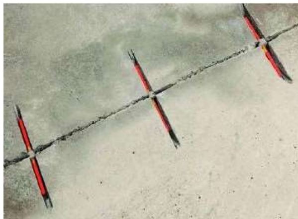
Рисунок 4. Установка стяжек в каналы, открытые в трещинах
