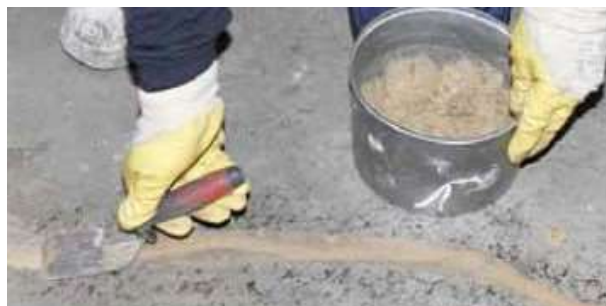
Рисунок 6. Выравнивание поверхности и трещин при помощи средства MasterInject/Masterflow.
